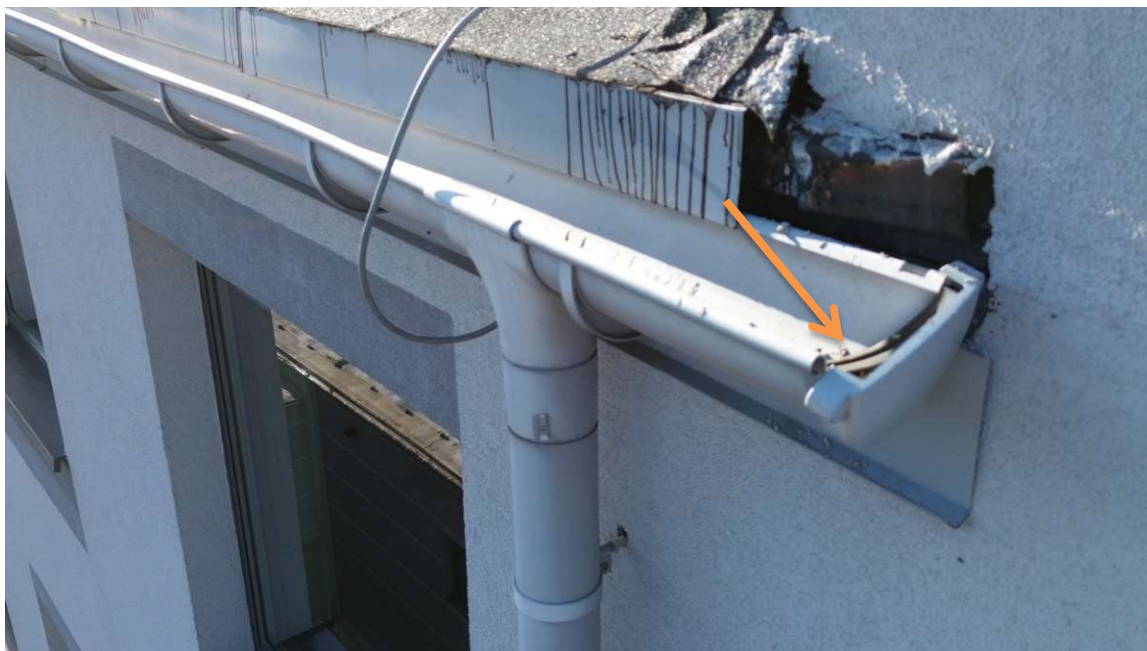
Fot. 10 – rozszczelnienie zaślepki orywnowania.
